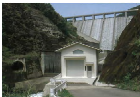
国営かんがい排水事業「大淀川左岸地区」の広沢ダムと小水力発電施設
