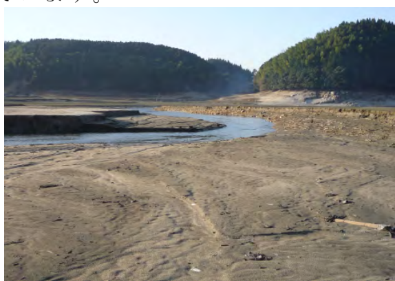
貯水池内の堆砂状況
