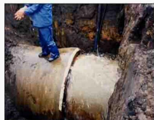
継目からの漏水 (幹線水路)
