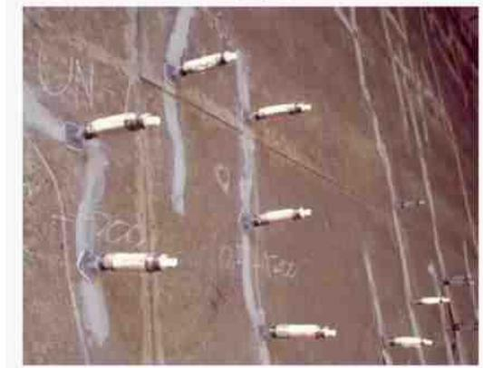
樹脂注入による止水の例
