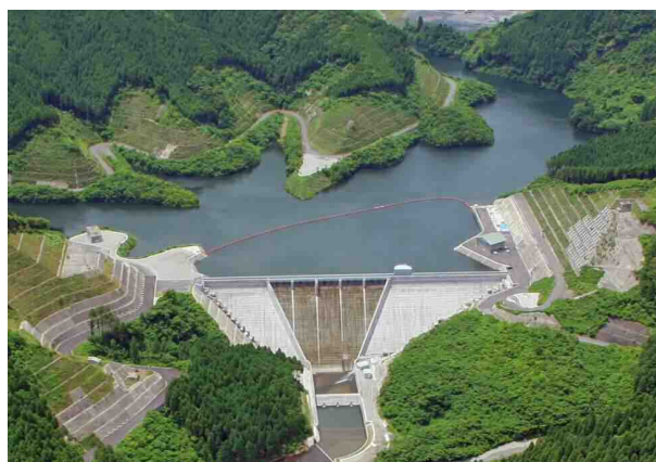
たにかわうち 谷川内ダム湛水状況写真
