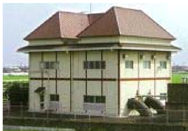
排水機場の整備
