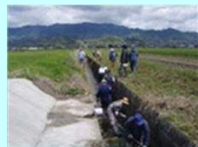
水路の泥上げ
