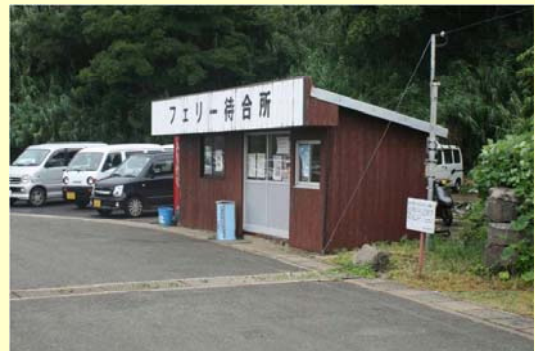
古い施設（改修前）の外観
