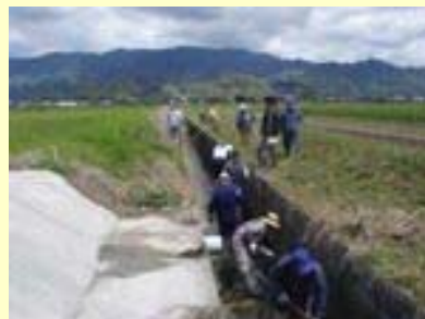
水路の泥上げ
