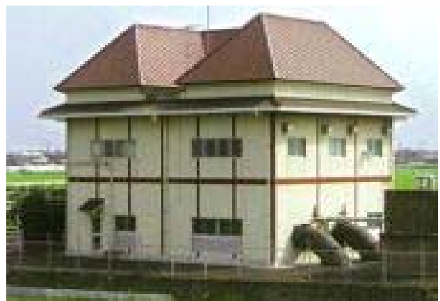
排水機場の整備
