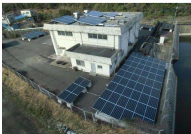
農山漁村活性化プロジェクト支援交付金 「 おかがき 岡垣地区」（福岡県 おかがまち 岡垣町）の太陽光パネル
