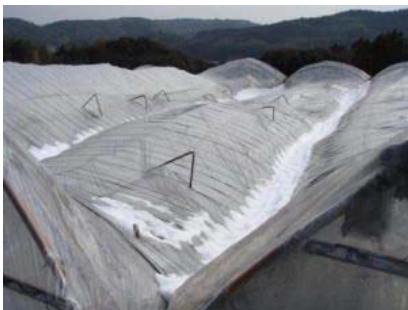
雪により損壊したぶどう栽培の ビニール施設 (大分県宇佐市：26年2月)
