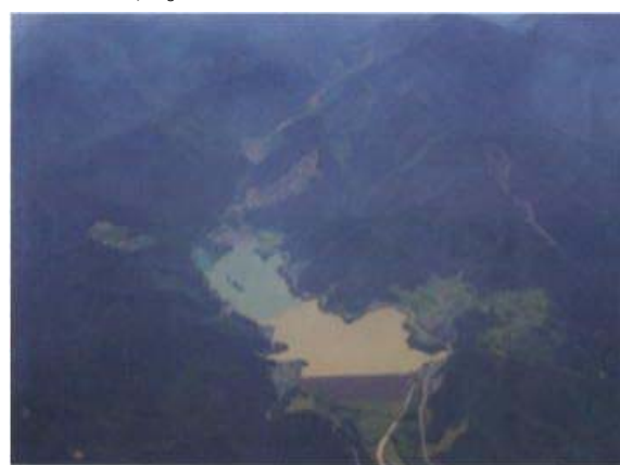
ダム上流の山腹崩壊に伴う貯水池堆砂と濁り
