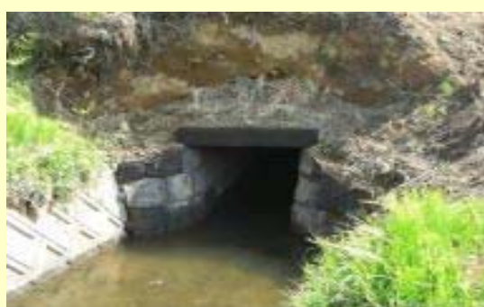
通潤用水（下井手13号水路上流坑口）
