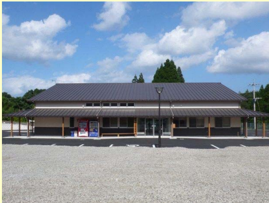
活性化施設（全景）
