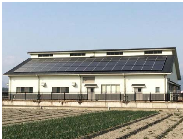
農山漁村活性化プロジェクト支援交付金 「須古地区」（佐賀県白石町）の太陽光パネル
