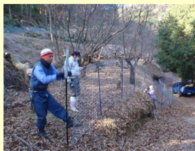
柵の施工の様子
