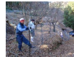
柵の施工の様子
