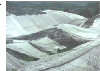
花き施設 損壊 (熊本県甲佐町)
