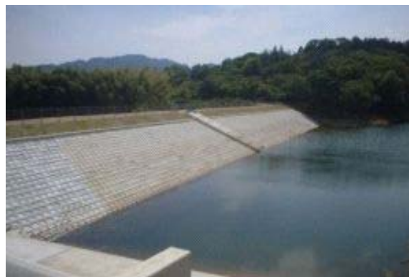
補強したため池
