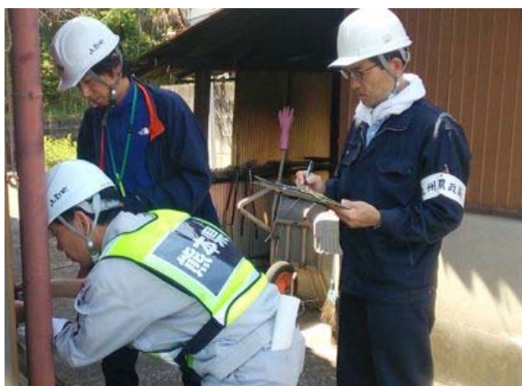
自治体職員と同行して、罹災証明書の発行に必要な住家被害認定調査の作業
