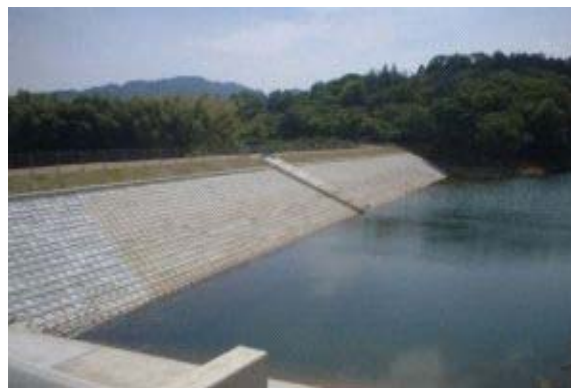
補強したため池
