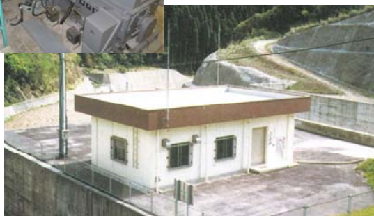
県営かんがい排水事業 「金峰地区」の小水力発電施設
