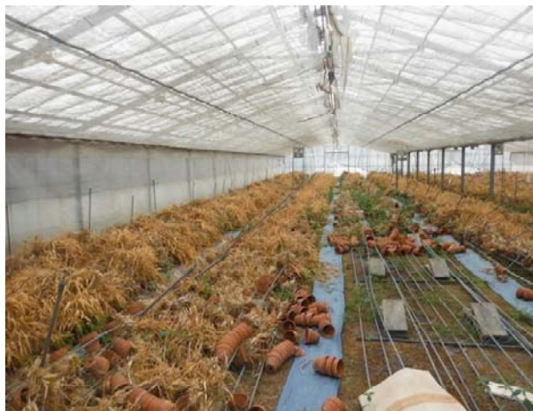
洋ランベンチ倒壊、灌水設備損壊による枯死
