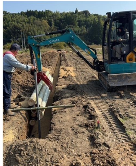
竹と竹チップで暗渠施工
