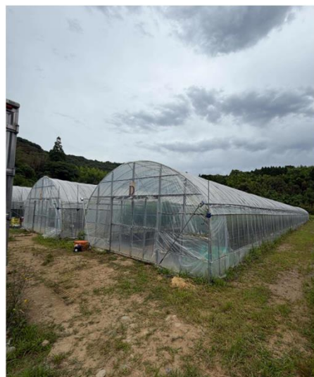
家族と施工したアスパラハウス
