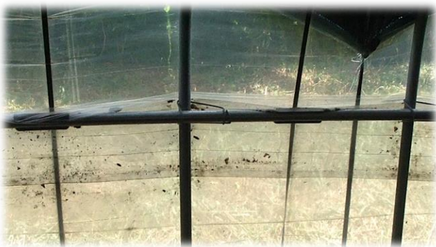
▲害虫の侵入を防ぐビニールの張り方
