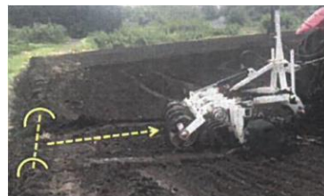
ほ場面の傾斜・均平化作業
