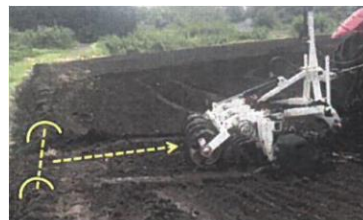
ほ場面の傾斜・均平化作業
