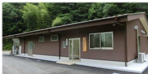
西米良村ジビエ処理加工施設
