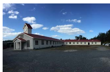
隣地に第 2 工場を稼働
