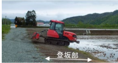
ターン農道の整備
