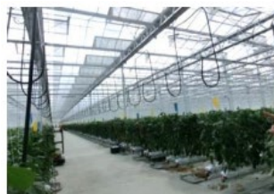
【環境制御システムの導入】
