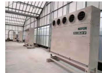
電力で加温するヒートポンプ(千葉県) 資料：千葉県千葉市
