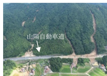
「平成30年7月豪雨」による荒廃状況
