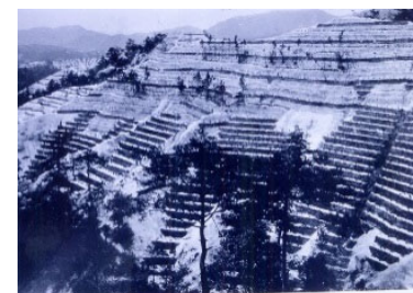
山腹工の施工 (1917年)
