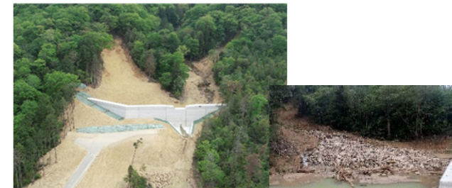
令和3年8月の大雨における治山ダムによる土砂の流出抑制
