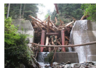
流木捕捉式治山ダムの 整備
