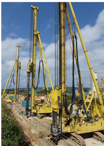
地下ダムの施工状況
