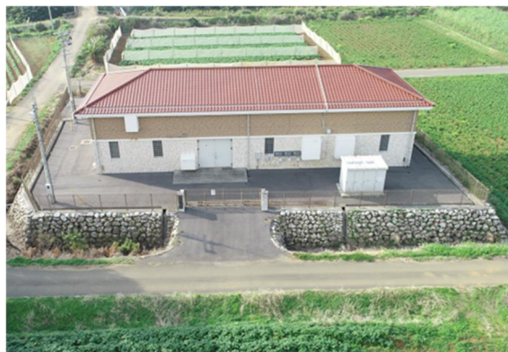
あまた 余多揚水機場
