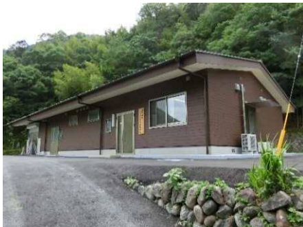
<西米良村ジビエ処理加工施設>
