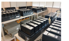
ドローンのバッテリー充電施設
