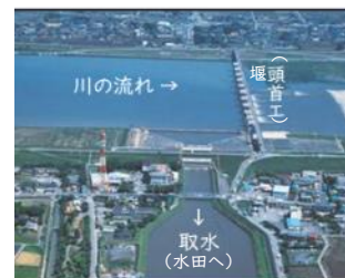
河川からの取水施設 （頭首工）
