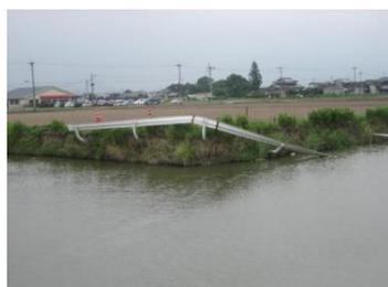
崩落土砂の堆積による貯留・排水機能の低下
