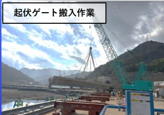
遥拝頭首工の改修作業
