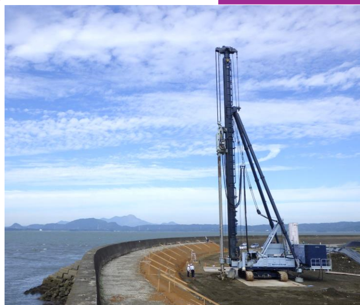
地盤改良工事
