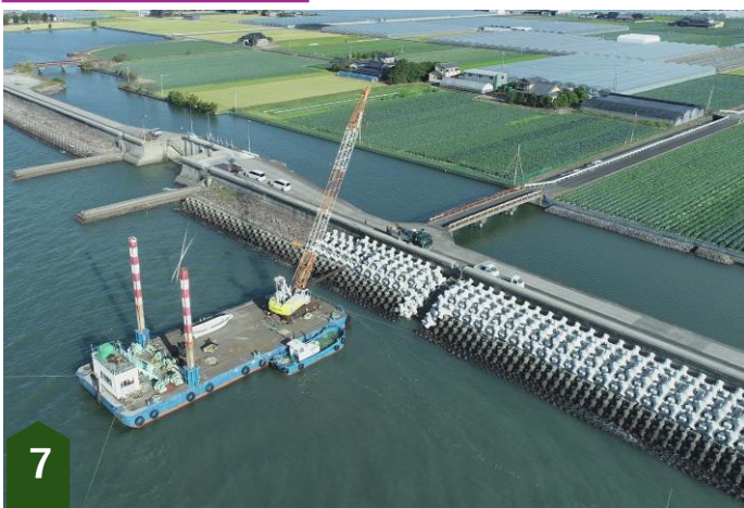
消波ブロック設置
