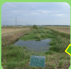
法面保護工施工前
