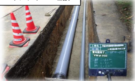
パイプラインの埋設
