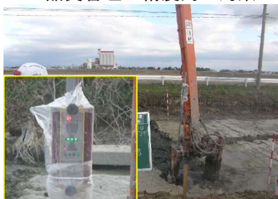
レーザーセンサーによる深度管理
