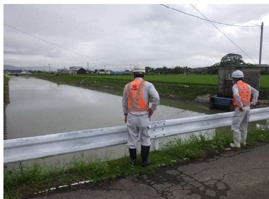
保安全管理状況 (大雨後の水路巡視状況)
