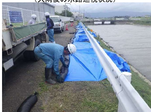
保安全管理状況 (被災箇所応急処置状況)
