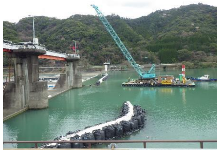
クレーン台船による施工（写真①）
