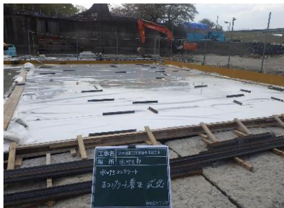
護床保護工（写真③） （水叩きコンクリート）
