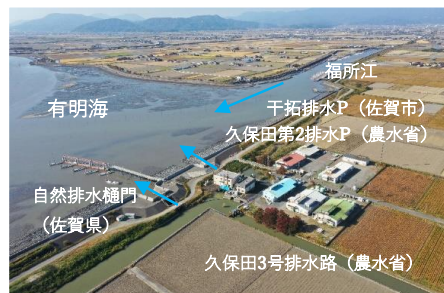
排水施設の状況
