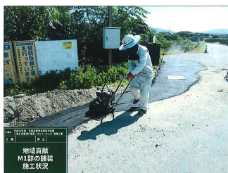
【農道のAs舗装補修】
