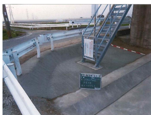
【防草の張コンクリート】
