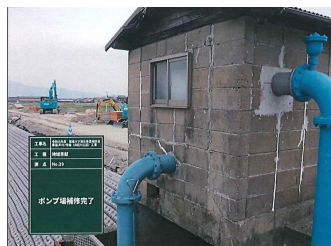
【ポンプ場の補修】
