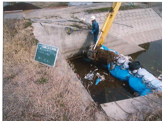
【水路の清掃作業】
