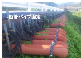
県道嵩上げ 配管ブレ止め(写真⑦)
