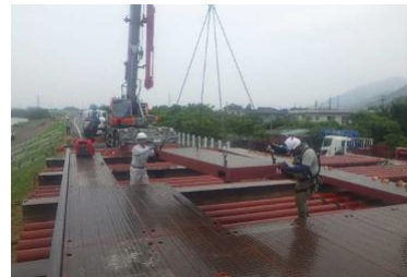
県道嵩上げ 覆工板設置(写真⑥)
