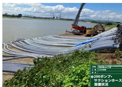
上工水水路部 ホース設置(写真⑤)
