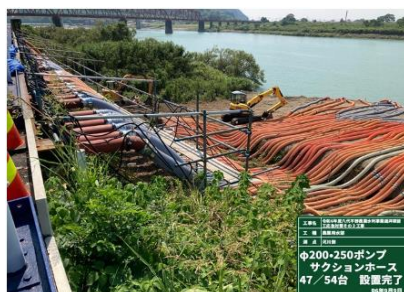
湾洞沈砂池部 ホース設置(写真④)
