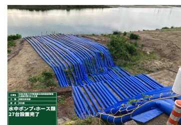
湾洞沈砂池部ホース設置(写真③)
