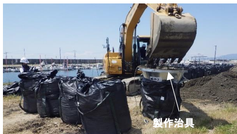
大型土のう製作(写真③)
