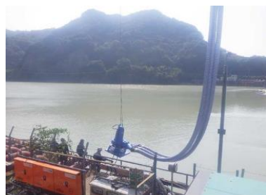
水中ポンプ設置状況(写真④)
