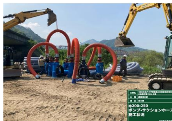
水中ポンプ設置状況(写真②)
