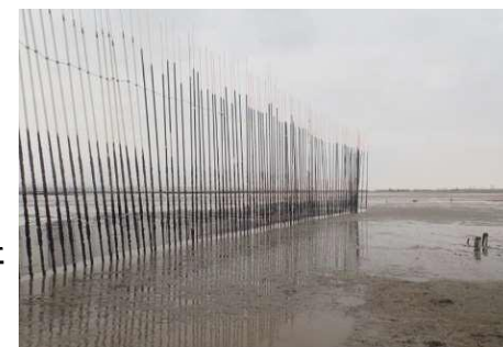
【写真1】試験区の設置(熊本県)
