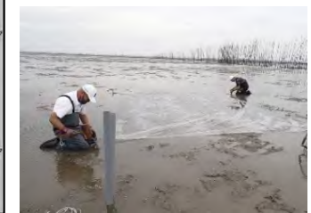
支柱・被覆網の設置 (冬季 波浪対策)
