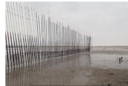
【写真1】試験区の設置(熊本県)
