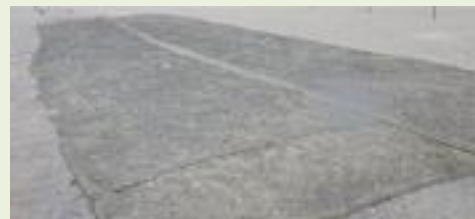
〔被覆網の設置状況(写真)〕
