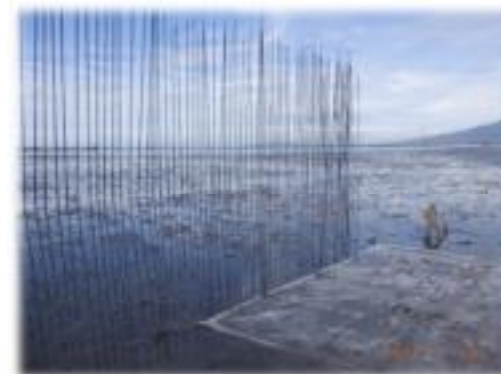
写真1 令和6年試験時の設置状況(川口)
