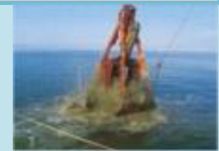
〔漁場造成：浚渫〕
