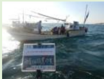
〔藻場礁の設置作業〕
