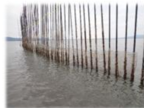
写真2 令和7年試験時の設置状況(川口) 防護網を追加設置
