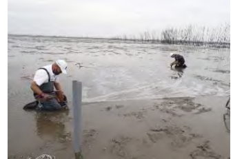
支柱・被覆網の設置 (冬季 波浪対策)
