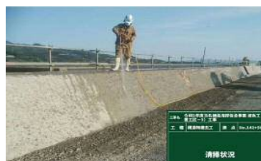
はつり面の高圧洗浄
