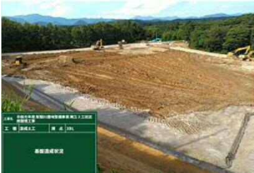
施工状況(運土調整)
