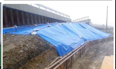
降雨時の盛土面保護
