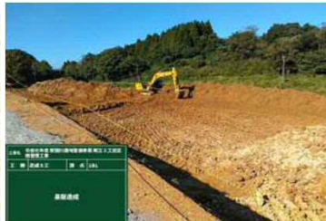
施工状況(基盤造成)
