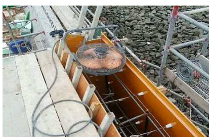
型枠内への送風
