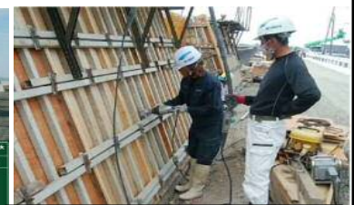
高周波パイプ、型枠パイプの併用
