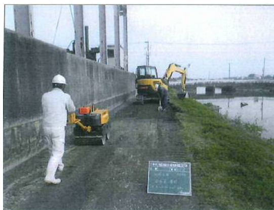
諸富土地改良区施設 保管理活動 (農道の補修作業)
