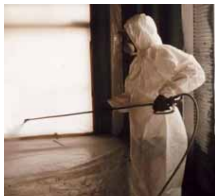
(薬液散布による石綿の湿潤化)
