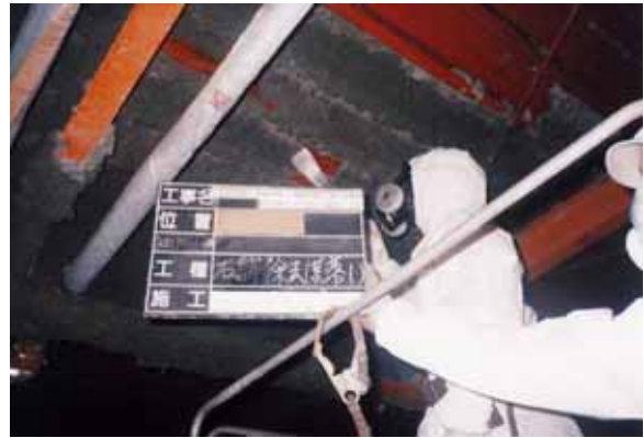
(石綿除去作業(手作業によるかき落とし))
