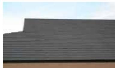
(住宅屋根スレート)****
