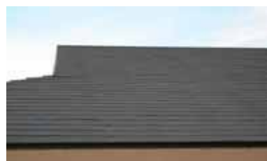
(住宅屋根スレート)****
