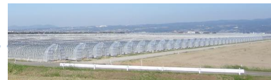
単棟ハウスの設置状況
