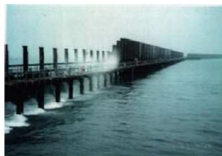
約 1.2km の瞬時締切り方式による潮受堤防の締切り (平成 9 年 4 月)
