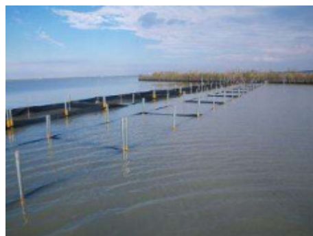
写真 3-4 ヨシ進出促進工近傍の波浪低減対策施設 設置状況
