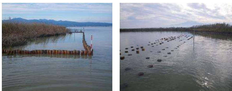
写真 3-3 潜堤内の波浪低減対策施設 設置状況
