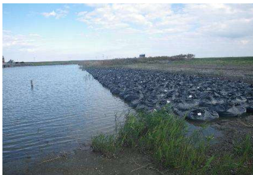
写真 3-9 上水場発生土の設置状況
