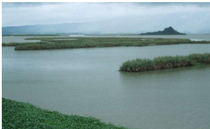
写真 3-2 ヨシ進出促進工の設置状況
