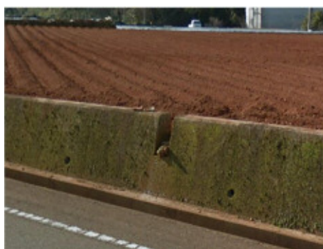
写真 3-17 稲わら等の設置による土壌流出抑制
