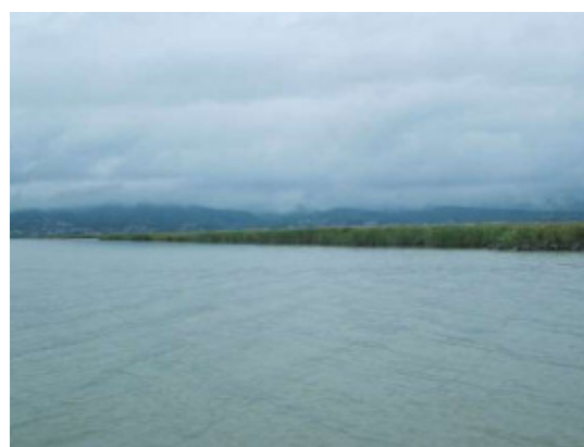
写真 3-1 潜堤の設置状況
